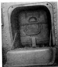
Фиг. 45. Установка аккумуляторной батареи на вертолетах с № 0152 в транспортном, санитарном и спасательном вариантах.
